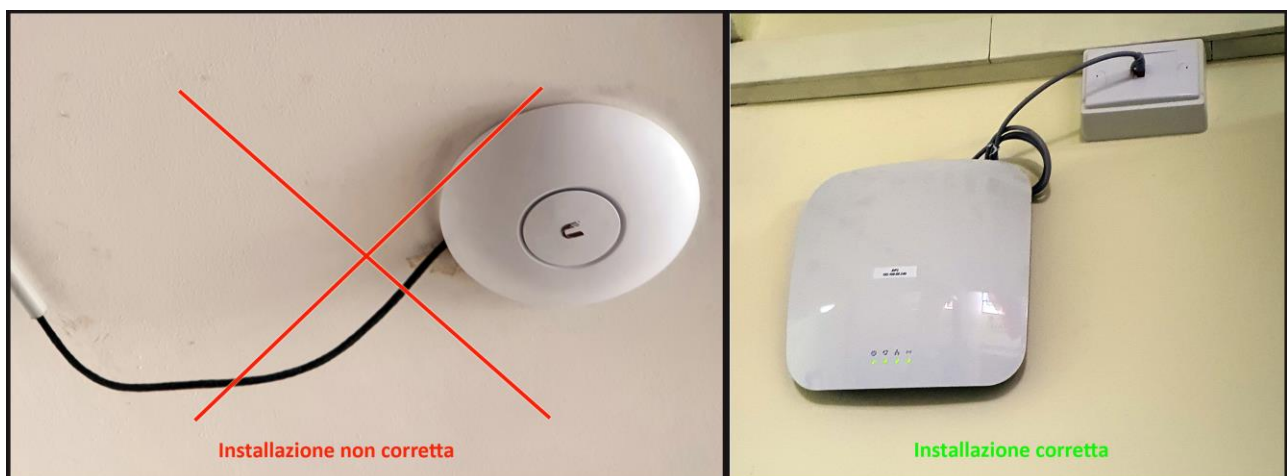
Figura 10 – Installazione corretta dell'Access Point
